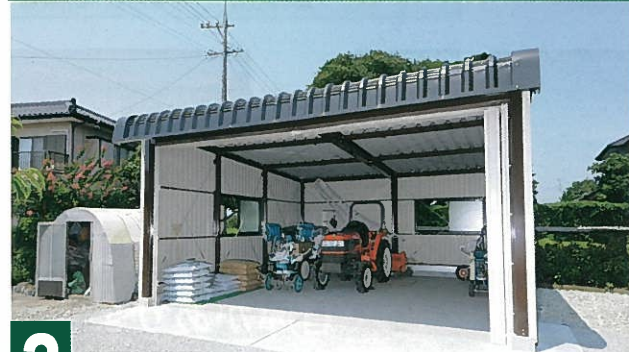
2 台用(間口6m) 上記施工例仕様 カラー: スタンダード ■KSW-2031 屋根 ディープレタン 壁 クリーム 柱 ダークブラウン
